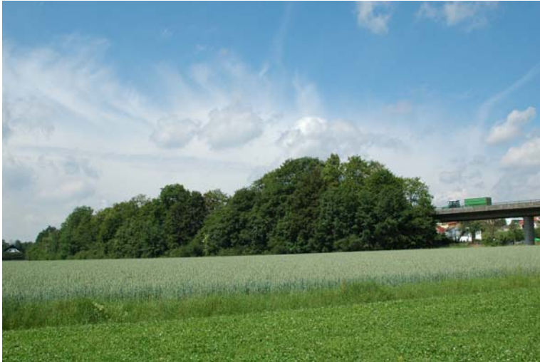
Straßenbegleitendes Gehölz an der südexponierten Böschung der westlichen Dammschüttung zur Querung der Eisenbahnlinie. Der Gehölzbestand ist ein typisches Beispiel der Baum-Strauchpflanzungen entlang der bestehenden B 388
