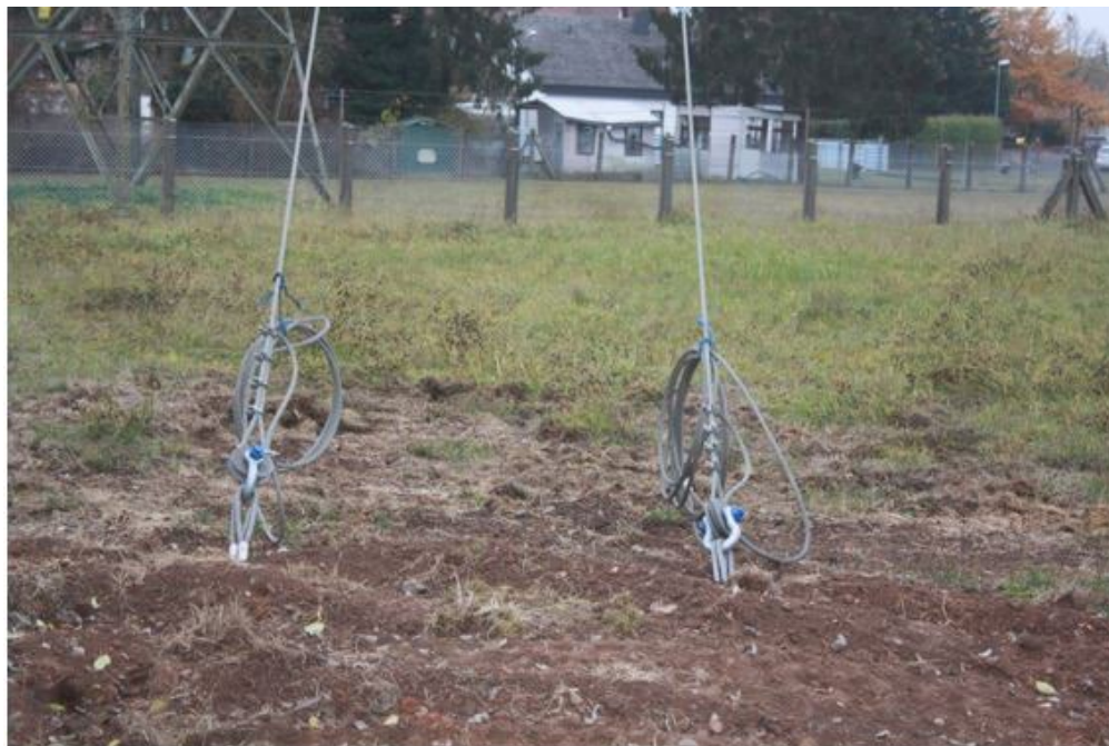
Abbildung 18: Bsp. ins Erdreich eingebrachte Abankerungen
