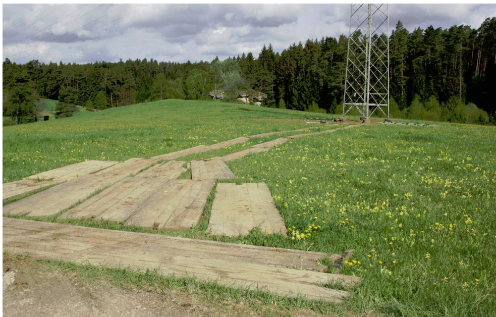
Abbildung 15: Bsp. Zuwegung über Holzplatten
