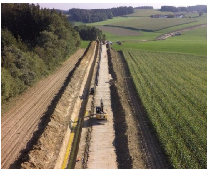
Abbildung 9: Bsp. Kabelverlegung mit offener Bauweise
