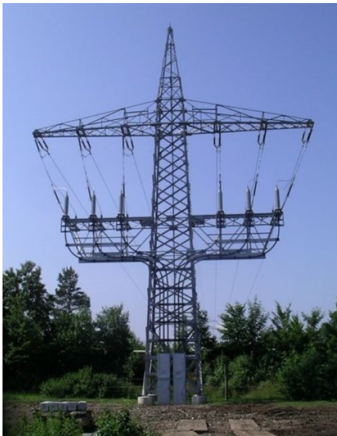
Abbildung 8: Bsp. Kabelübergangsmast
