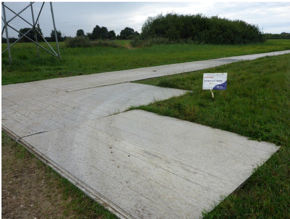
Abbildung 14: Bsp. Zuwegung über Aluplatten
