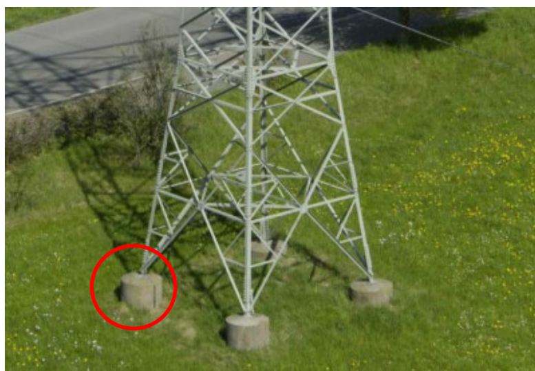
Abbildung 6: Bsp. sichtbare Betonfundamentköpfe
