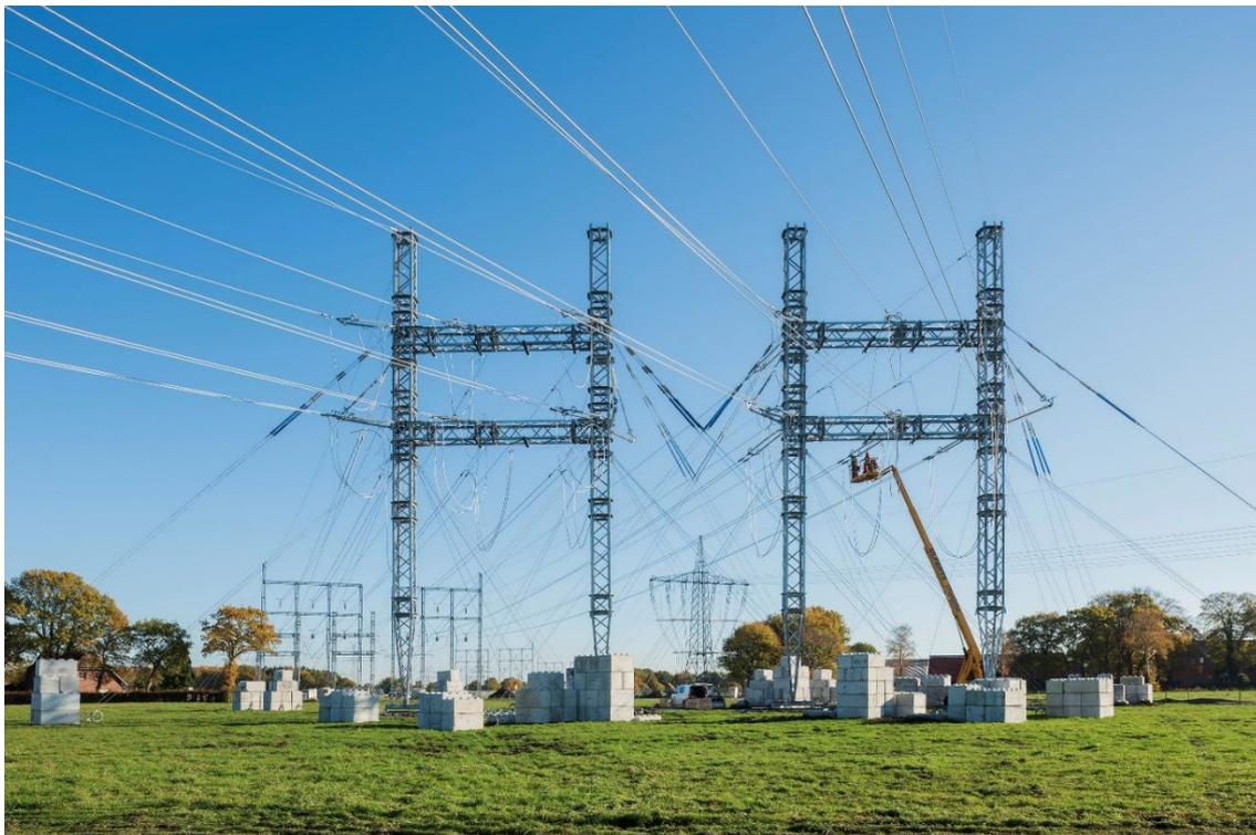
Abbildung 14: 380-kV Freileitungsprovisorium für zwei 380-kV Stromkreise
