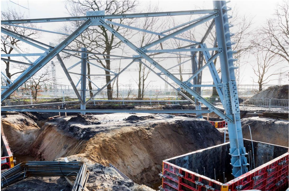
Abbildung 19: Stufenfundament
