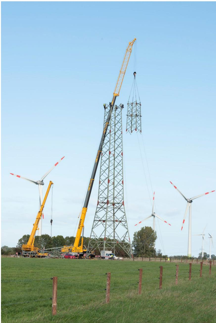
Abbildung 21: Mastmontage mittels Mobilkran
