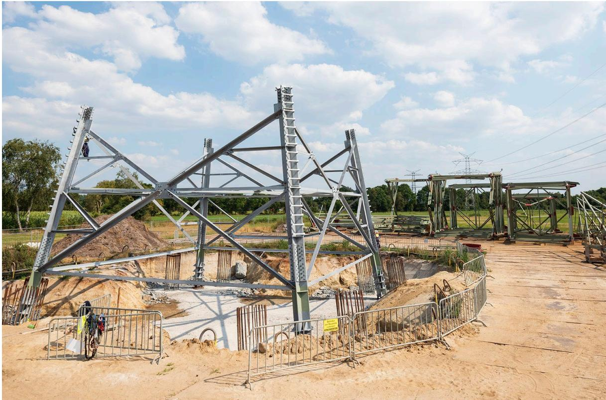
Abbildung 20: Plattenfundament
