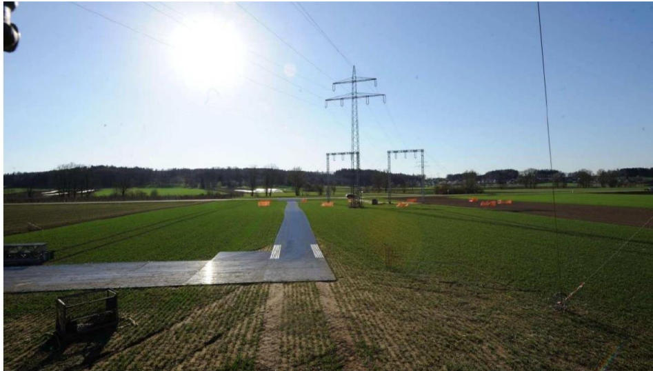
Abbildung 1: Provisorische Zuwegung als Plattenzufahrt bei einer Freileitungsbaustelle
