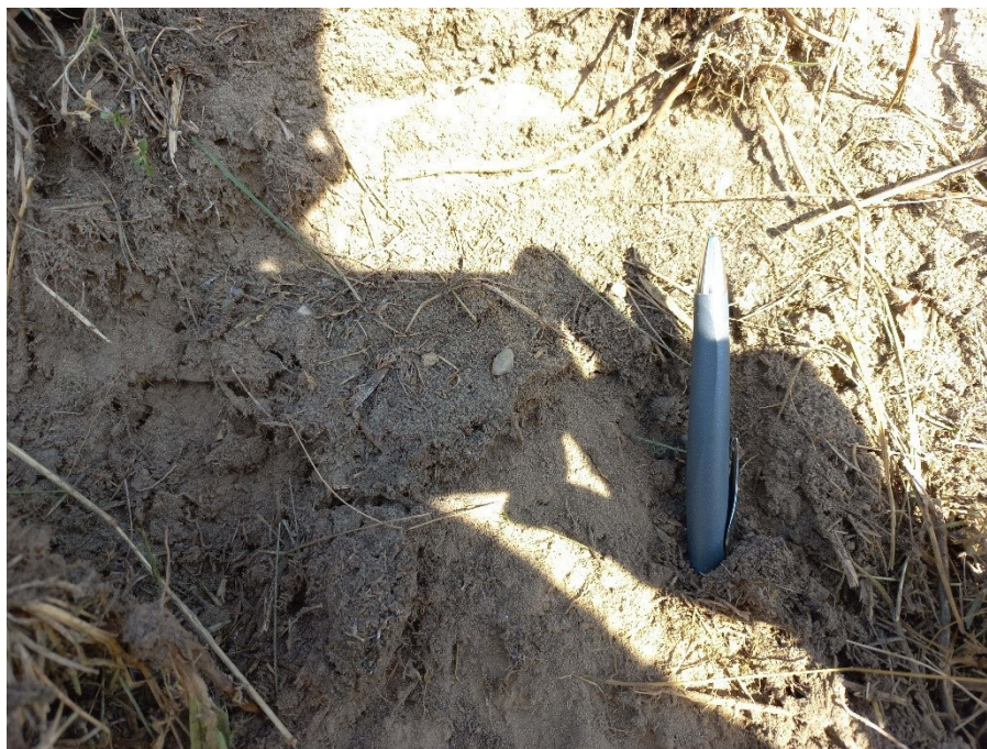
Foto 45: (F-C-45 in Anlage 1.9) Bereich Mastnummer 27 Blickrichtung N
