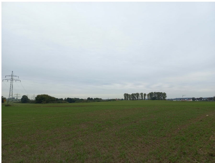
Foto 23: (F-C-23 in Anlage 1.9) Bereich Mastnummer 6 Blickrichtung O
