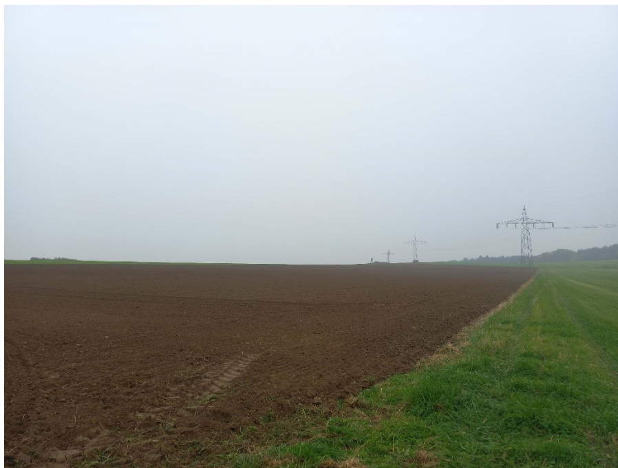
Foto 29: (F-C-29 in Anlage 1.9) Bereich Mastnummer 14 Blickrichtung SW
