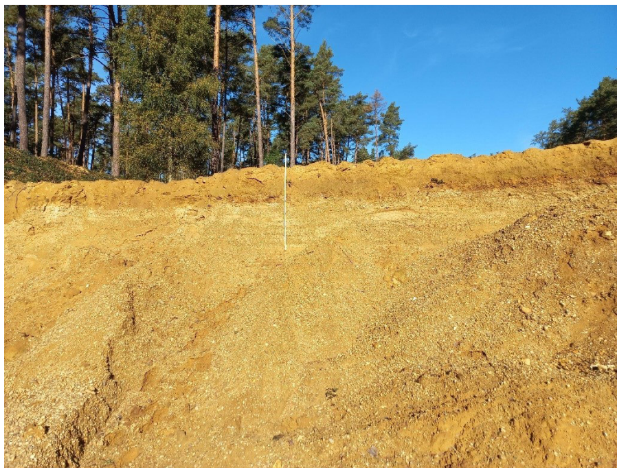
Foto 41: (F-C-41 in Anlage 1.9) Bereich Mastnummer 22 Blickrichtung NNW
