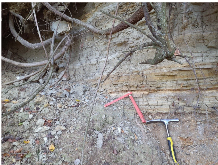
Foto 6: (F-C-06 in Anlage 1.9) Bereich Mastnummer 66 Blickrichtung NNO
