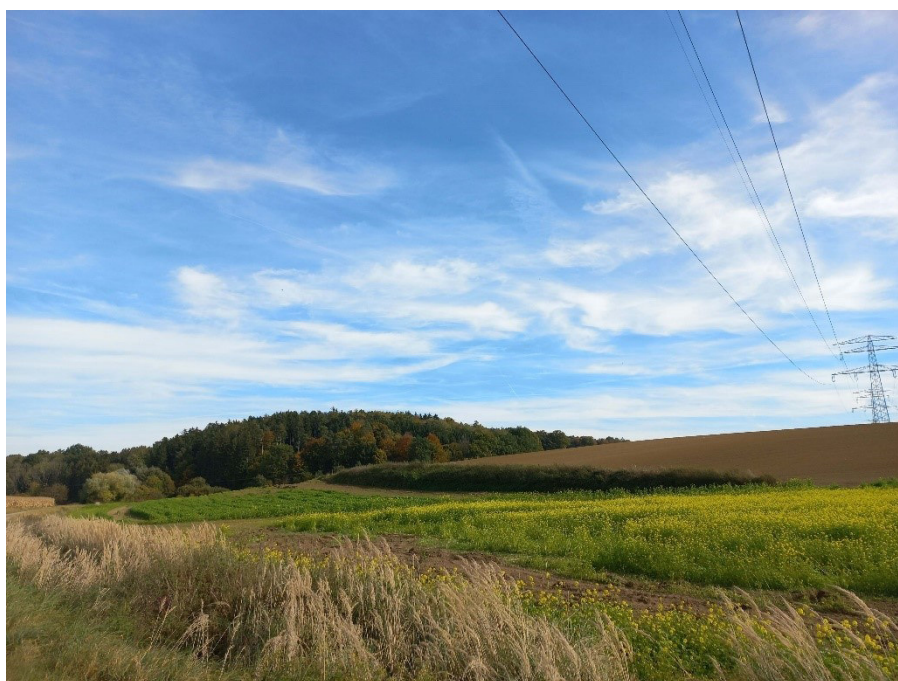
Foto 50: (F-C-50 in Anlage 1.9) Bereich Mastnummer 39 Blickrichtung O
