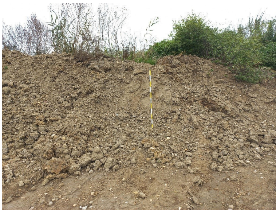
Foto 26: (F-C-26 in Anlage 1.9) Bereich Mastnummer 10 Blickrichtung NNW
