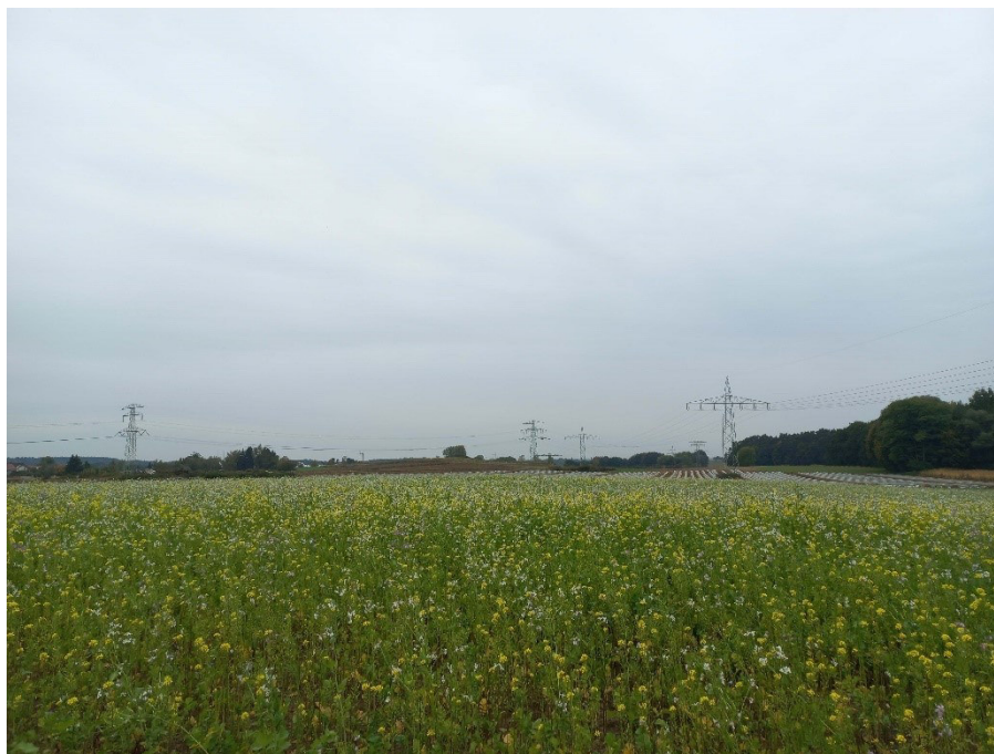
Foto 25: (F-C-25 in Anlage 1.9) Bereich Mastnummer 10 Blickrichtung SW
