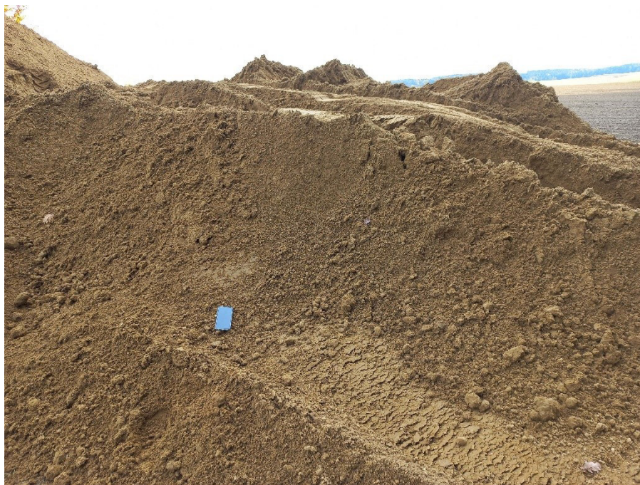
Foto 55: (F-C-55 in Anlage 1.9) Bereich Mastnummer 44 Blickrichtung SO
