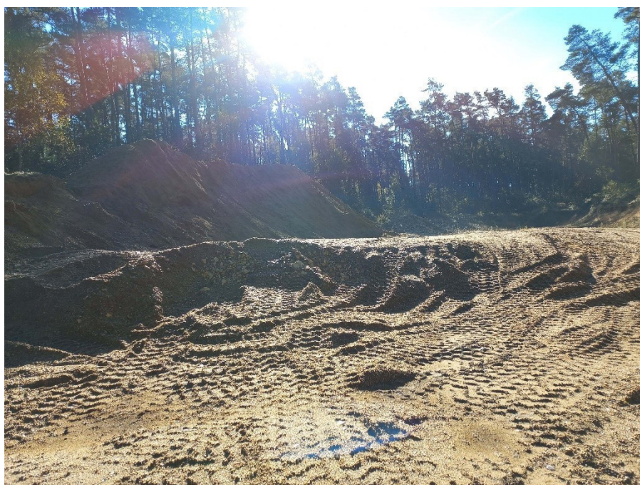
Foto 42: (F-C-42 in Anlage 1.9) Bereich Mastnummer 22 Blickrichtung SSO
