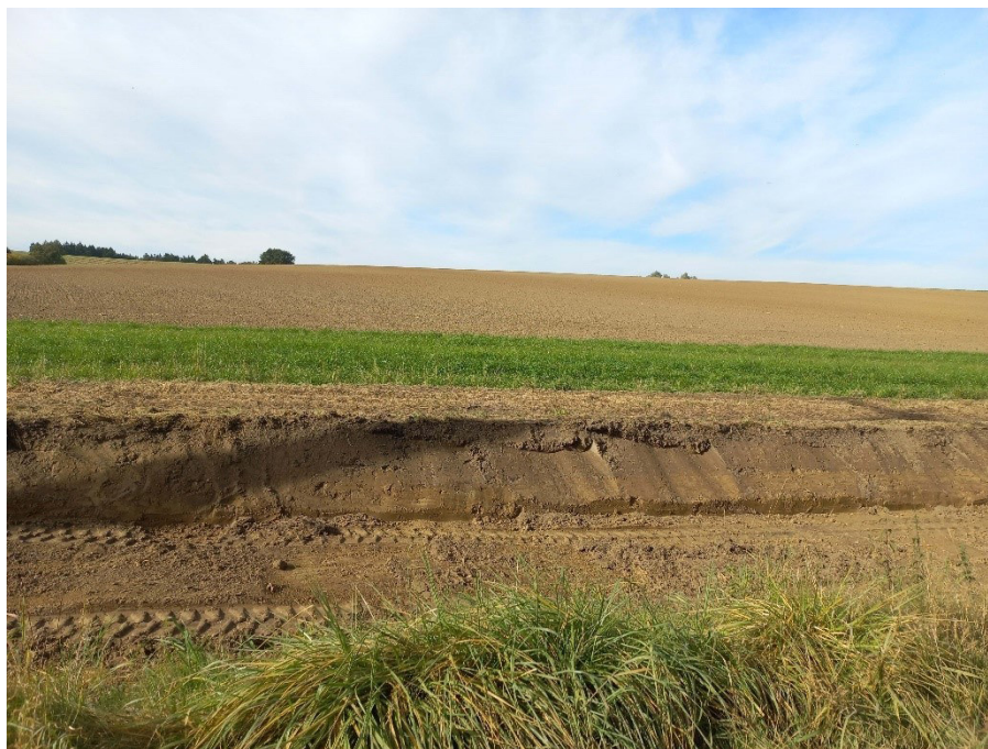
Foto 51: (F-C-51 in Anlage 1.9) Bereich Mastnummer 40 Blickrichtung W
