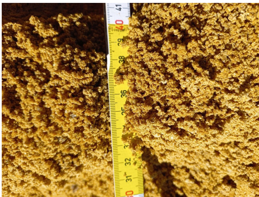
Foto 38: (F-C-38 in Anlage 1.9) Bereich Mastnummer 22 Blickrichtung N
