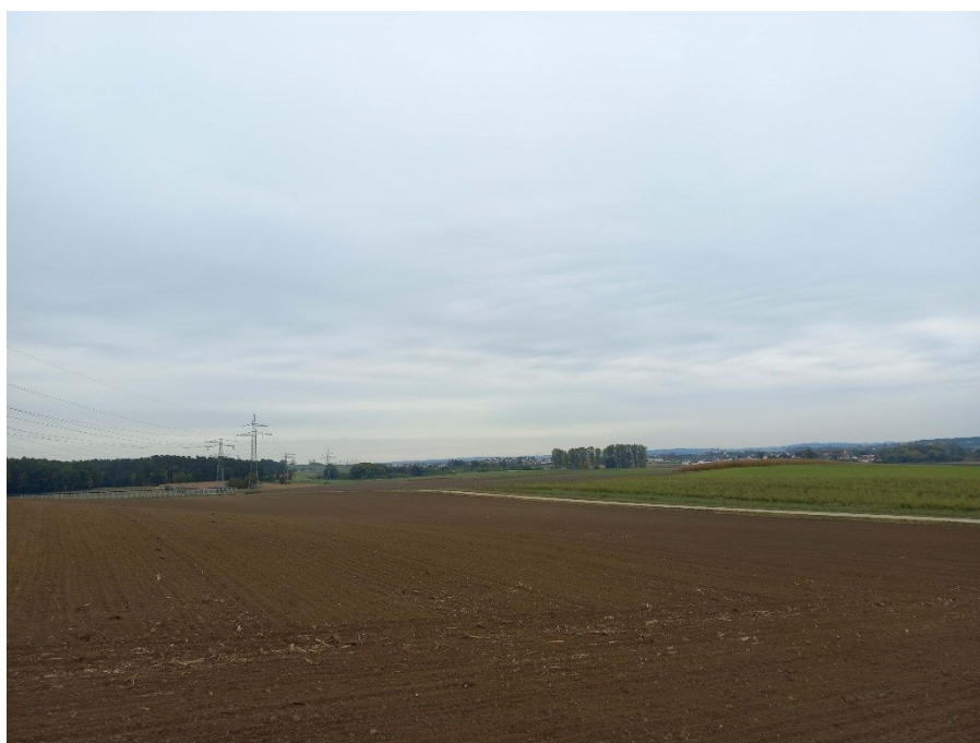
Foto 20: (F-C-20 in Anlage 1.9) Bereich Mastnummer 5 Blickrichtung O
