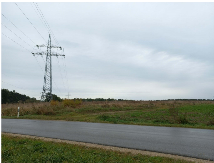
Foto 19: (F-C-19 in Anlage 1.9) Bereich Mastnummer 3 Blickrichtung O
