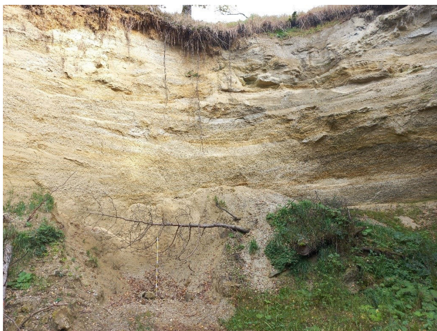
Foto 64: (F-C-64 in Anlage 1.9)
