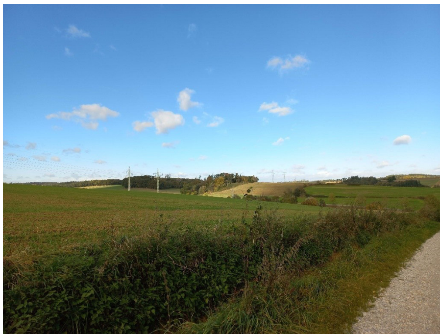
Foto 76: (F-C-76 in Anlage 1.9) Bereich Mastnummer 115 Blickrichtung WSW
