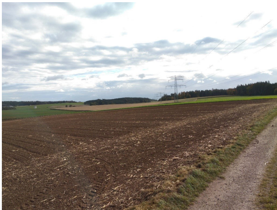
Foto 9: (F-C-09 in Anlage 1.9) Bereich Mastnummer 92 Blickrichtung O
