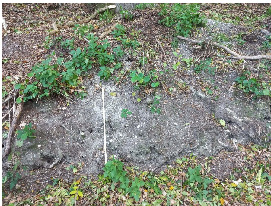
Foto 66: (F-C-66 in Anlage 1.9) Bereich Mastnummer 119 Blickrichtung NNO
