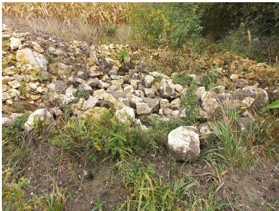
Foto 27: (F-C-27 in Anlage 1.9) Bereich Mastnummer 11 Blickrichtung OSO
