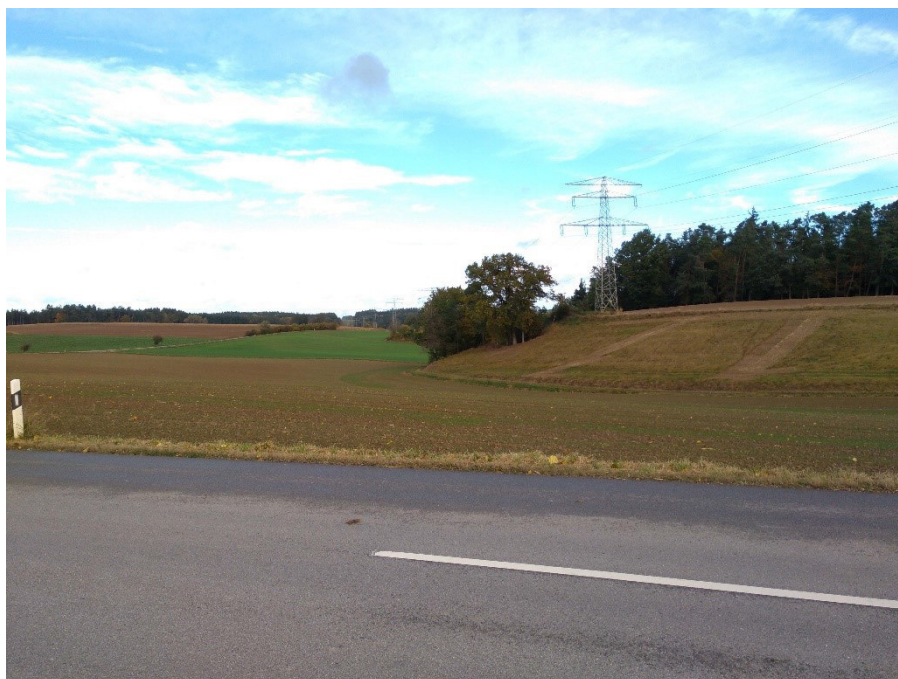
Foto 4: (F-C-04 in Anlage 1.9) Bereich Mastnummer 83 Blickrichtung NW
