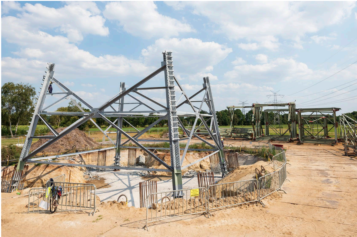
Abbildung 20: Plattenfundament
