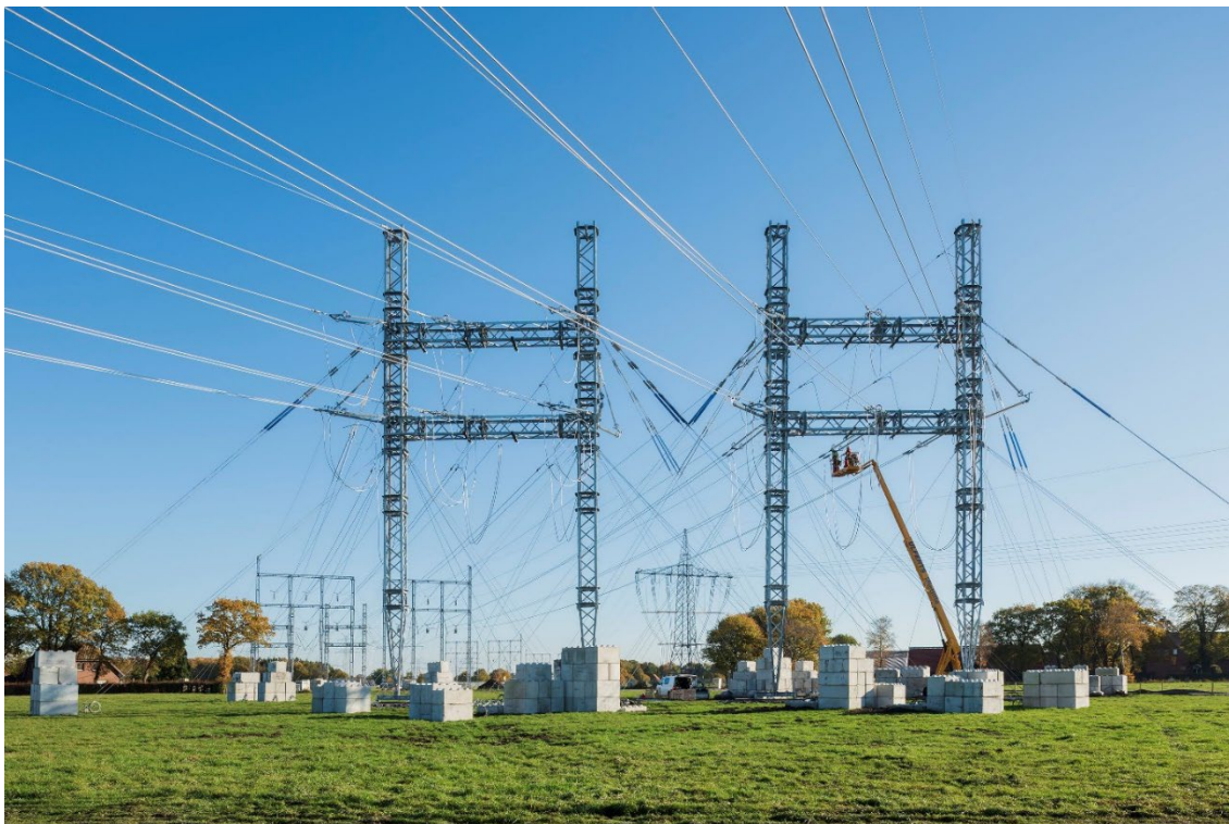
Abbildung 14: 380-kV Freileitungsprovisorium für zwei 380-kV Stromkreise
