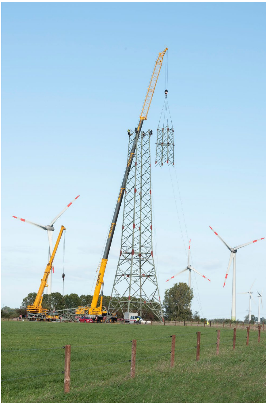
Abbildung 21: Mastmontage mittels Mobilkran
