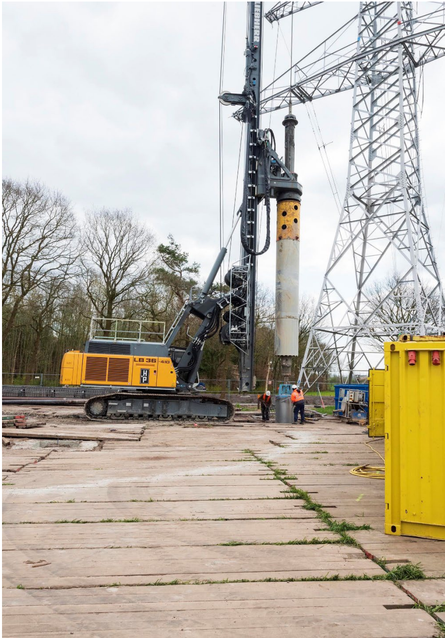
Abbildung 17: Bohrfahlgründung
