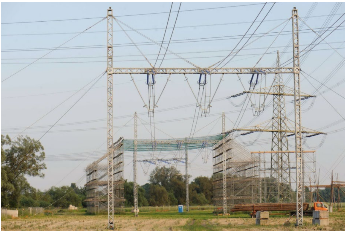
Abbildung 15: 380-kV Freileitungsprovisorium für ein System mit errichtetem Schutzgerüst
