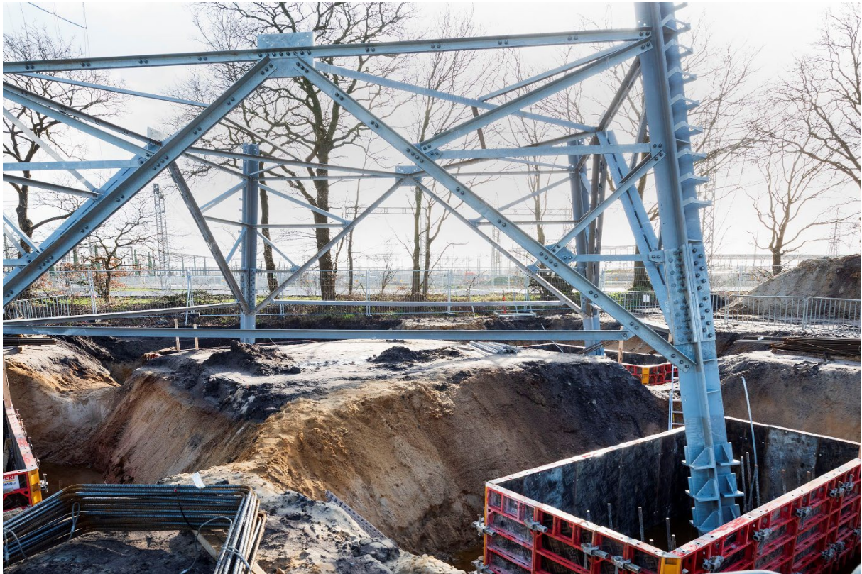
Abbildung 19: Stufenfundament
