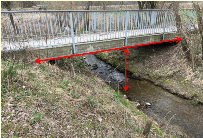
Abbildung 1-9: Geh- und Radwegquerung mittels 1-Feld-Träger (aquasoli 2024)
