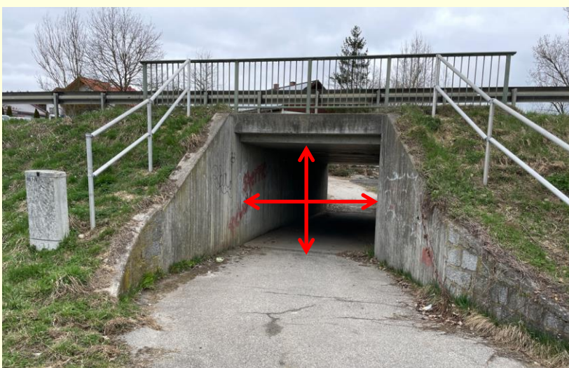
Abbildung 1-10: Geh- und Radwegdurchführung mittels Rahmendurchlass (aquasoli 2024)
