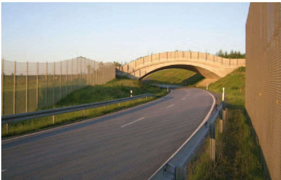
Abbildung 3: Zäune mit Leitfunktion im Übergang zu begrünten Heckenbrücken und Grünbrücken (aus Brinkmann et al. 2012)
