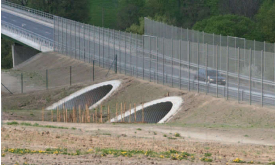
Abbildung 2: Fledermausdurchlässe in Verbindung mit Leitpflanzungen und trassenparallelen 4 m hohen Zäunen mit Leitfunktion an der S 170n nördlich Friedrichswalde-Ottendorf (aus Brinkmann et al. 2012)
