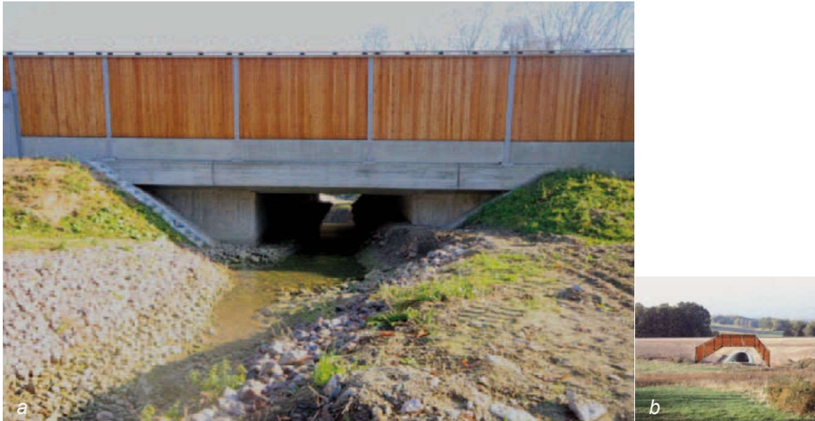
Abbildung 4: a) „Unterführung eines Baches (A 5 bei Offenburg) mit Irritationsschutzwand“ b) „Fließgewässerunterführung Sperreinrichtung“
