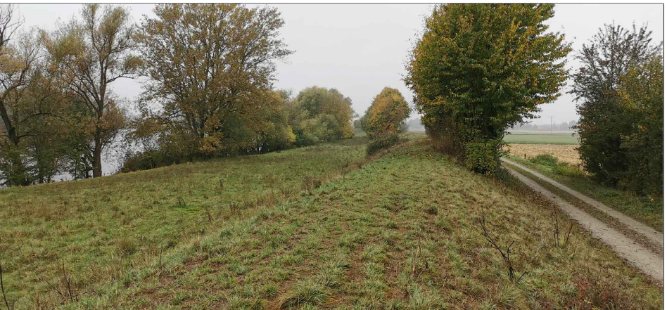
Blickrichtung Nordwest: Deichabschnitt 1 bei Deich-km 2+300
