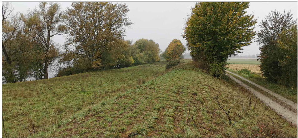
Blickrichtung Nordwest: Deichabschnitt 1 bei Deich-km 2+300
