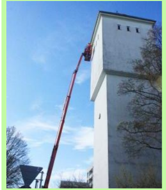
Anbringung der Nisthilfen am Landshuter Wasserturm mittels Hubsteiger (Foto: M. Alvarez, Stadt Landshut)
