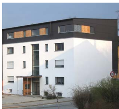
Saniertes Gebäude mit Aufstockung
