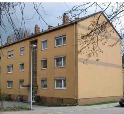
Zustand vor Sanierung
